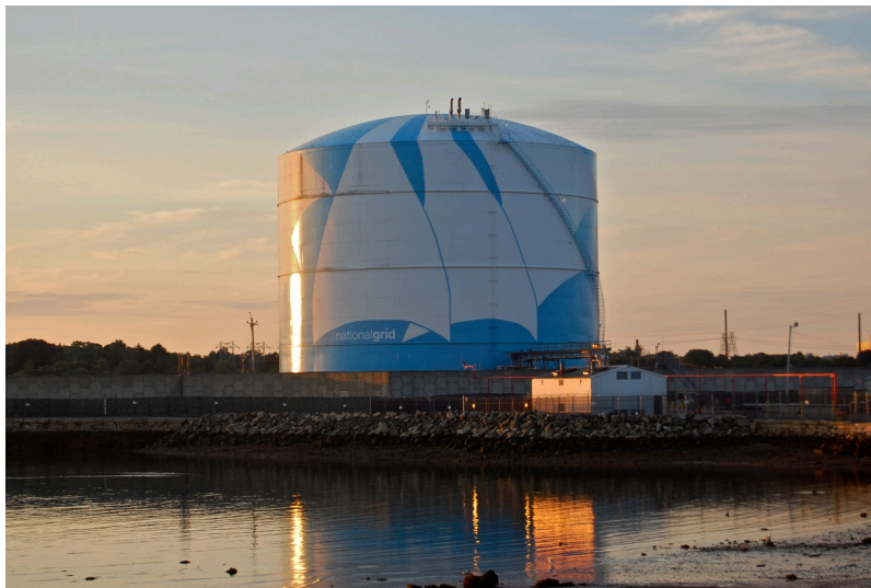
Figure 4. LNG storage tank.
